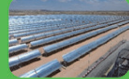
太陽光発電設備
